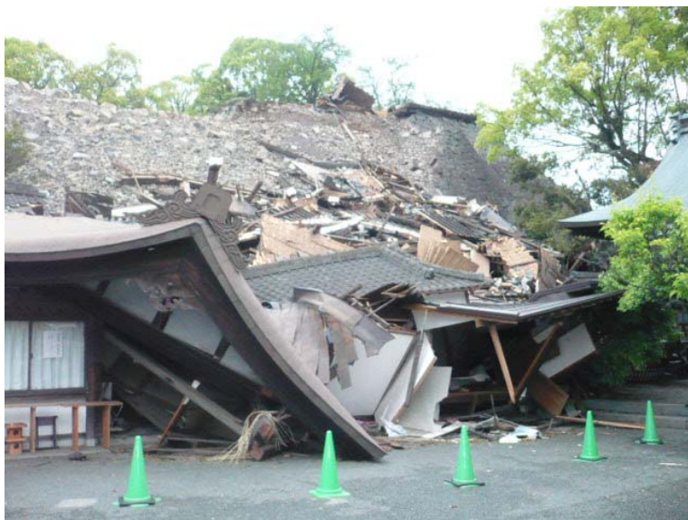
熊本城の近隣神社施設の損壊
