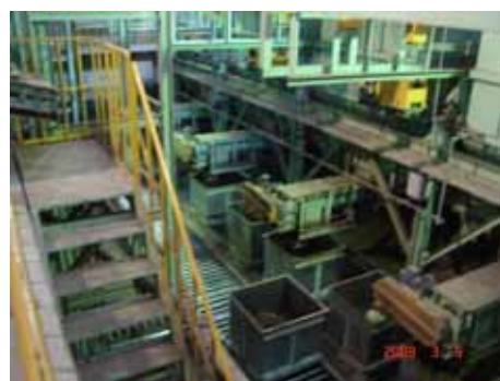
投入・攪拌状況
