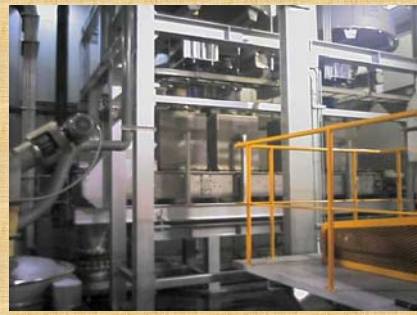
原料貯蔵・自動配合システム
