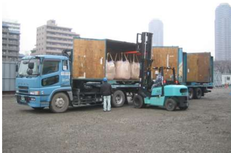
建設現場(東京都内)でフレコン詰めされた汚染土壌の積み込み
