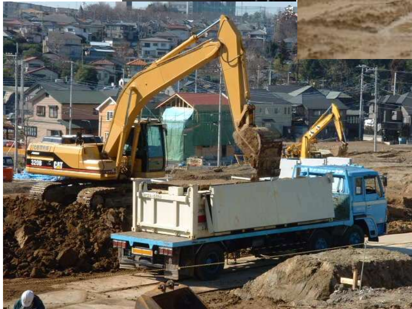
掘削現場での発生土の積み込み
