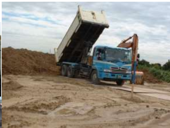
ダンプアップによる土砂の取卸し
