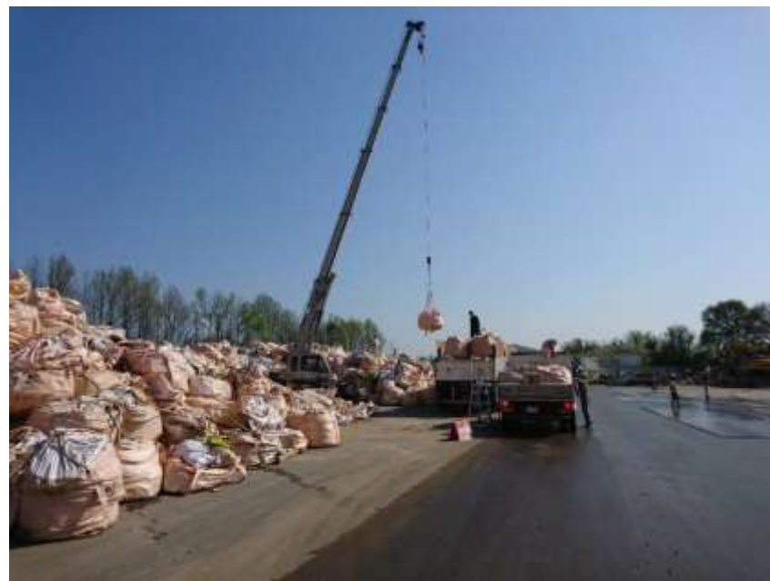
石綿含有建材搬出状況
