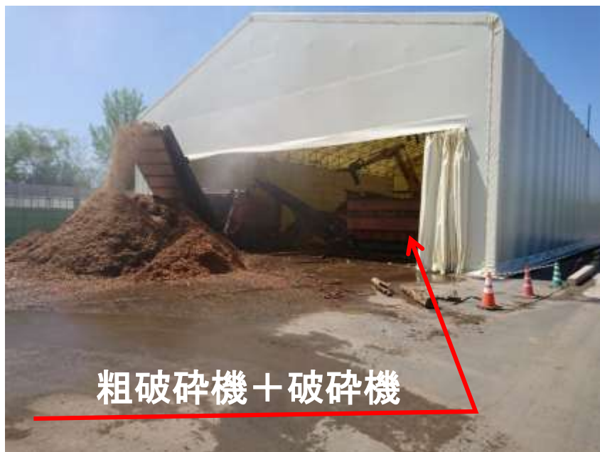
木くず破碎状況
