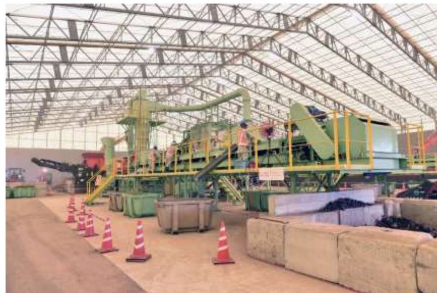
解体残渣分別状況
