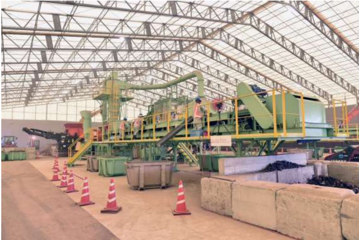
解体残渣分別設備
