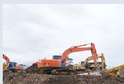
二次仮置場（宮城県気仙沼市）
