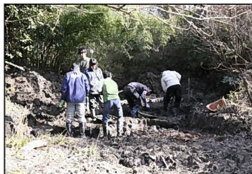
遮水シートの埋め込み作業
