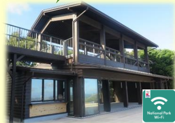
展望休憩所 (カフェコーナー・無料休憩スペース)
