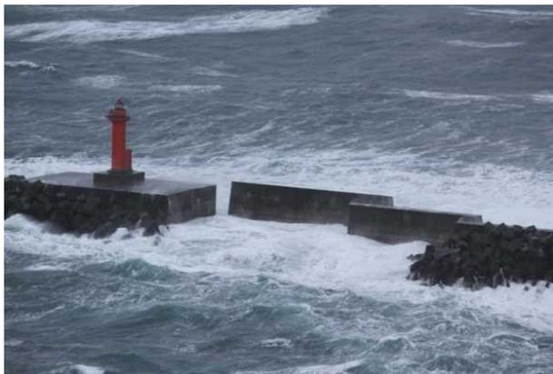
高波による防波堤の被災例
