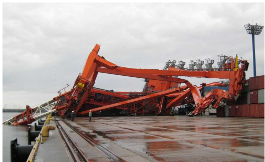
コンテナクレーンの逸走事故例
