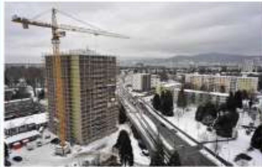
高層建築のエネルギー改修
