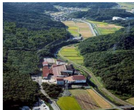
自然と共に歩む「関工場」全景
