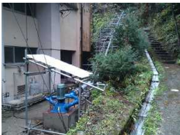
写真 10 宇奈月公民館裏の小水力発電装置
