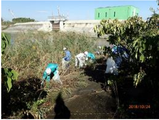
ごみ撤去作業（戸田茶屋排水機場南）
