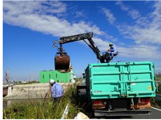
ごみ撤去作業（戸田茶屋排水機場南）
