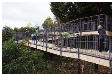
スロープ改修
