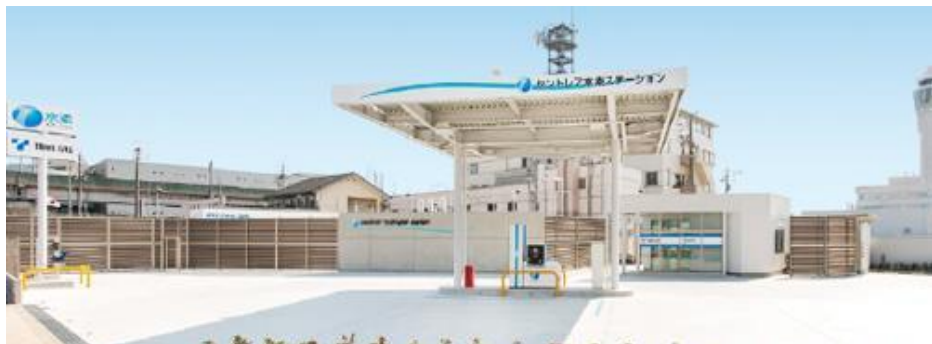
水素ステーション例 (セントレア水素ステーション)
