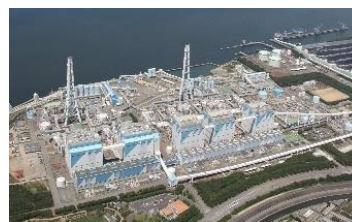
碧南火力発電所
