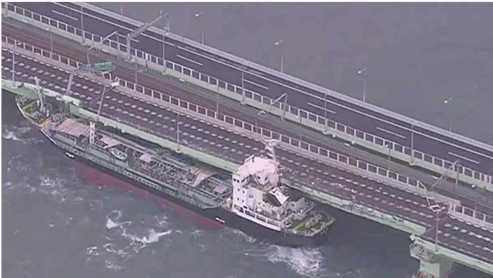
大阪府泉佐野市 関西国際空港ではタンカーが走錨して連絡橋に衝突した （画像：国土交通省）
