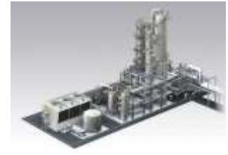
CO 2 回収プラント
