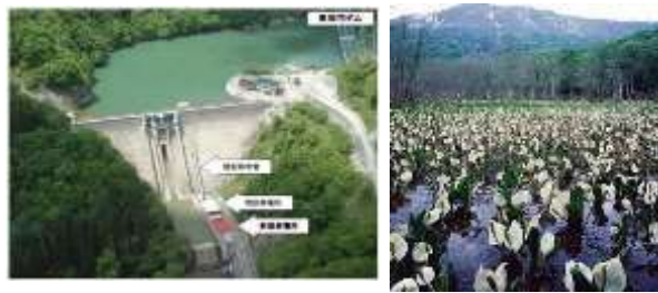
水芭蕉発電所（長野市） （出力980kW 約1,400世帯分を発電）
