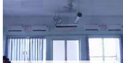
高効率エアコン及びEMS (三菱電機。ベトナム)
