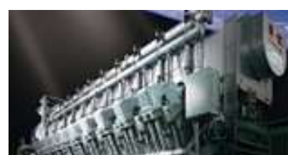
ジョイントエネルギーシステム (トヨタ自動車インドネシア工場) (新日鉄住金エンジニアリング。タイ)
