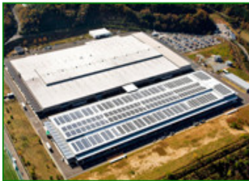
DREAM Solar 岡山工場
