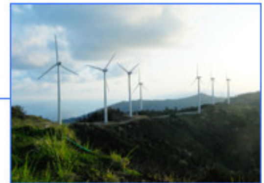
佐田岬風力発電所
