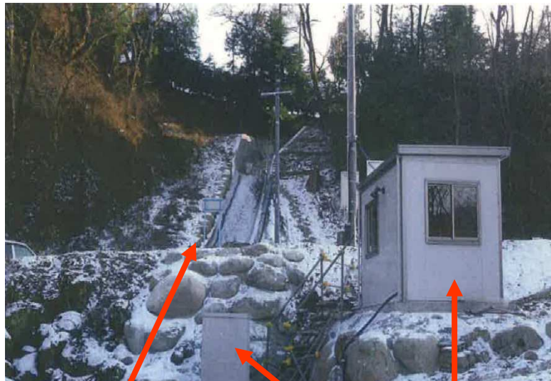
中央上に導管、中央下に発電機、 右の建屋内にパワーコンディショナー
