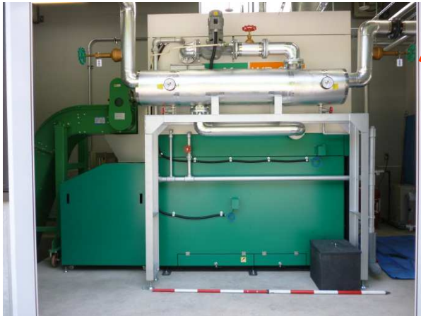
木質チップボイラー
